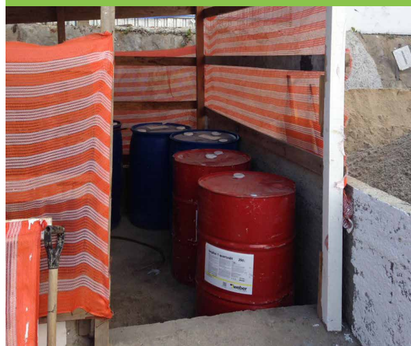
Baia de produtos químicos na obra Sonata
