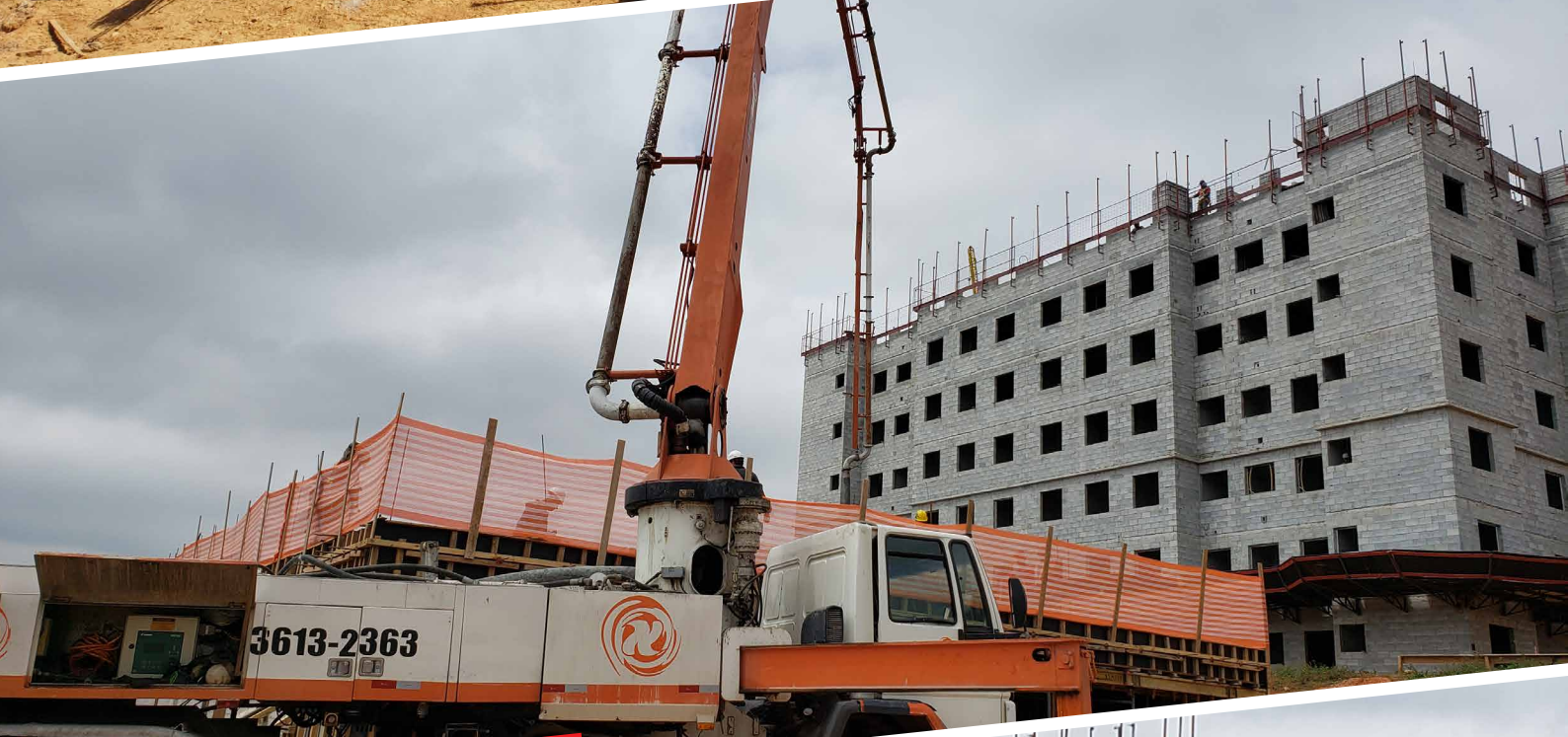
Construção do empreendimento Terra Nostra, em Guarulhos/SP
