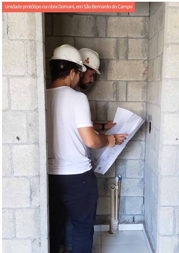
Unidade protótipo na obra Domani, em São Bernardo do Campo
