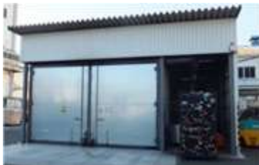
溶融固化施設
