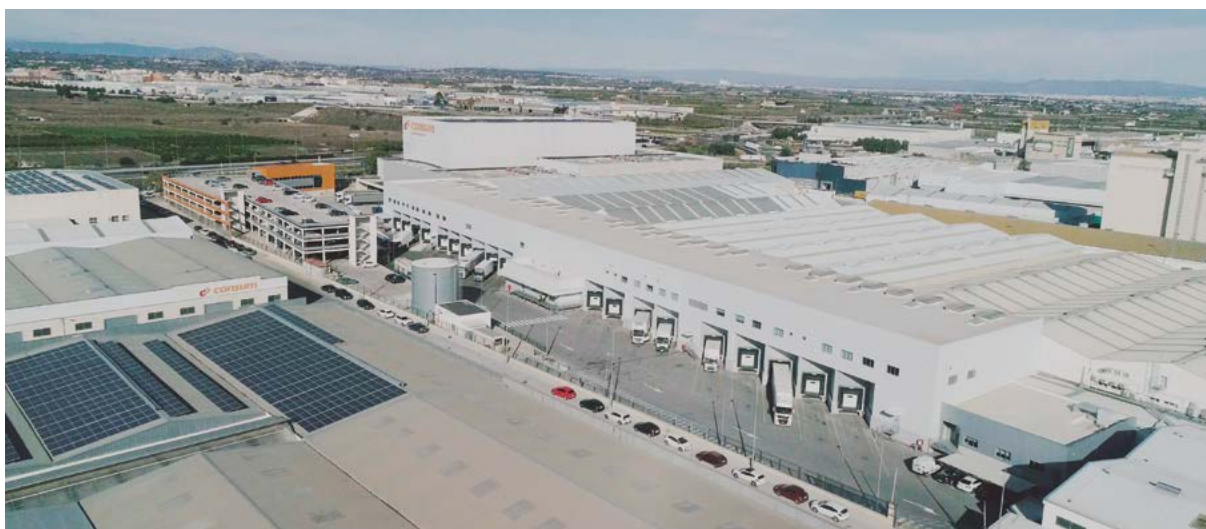
Vista aérea ampliación de la Plataforma Logística de Silla
