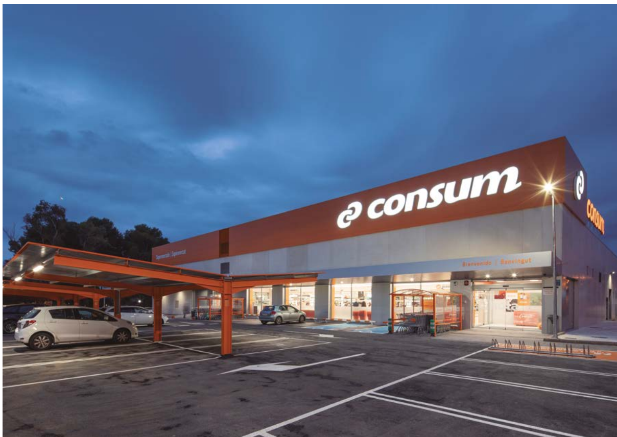
Fachada y parking del supermercado de Benicàssim
