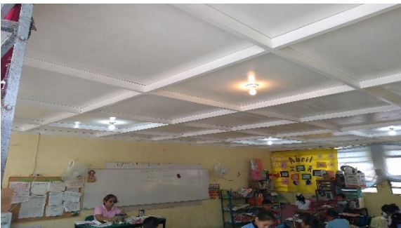
Rehabilitación de techos en aulas, Esc. Primaria Fernando Aguirre Colorado, comunidad el Desecho, Huimanguillo, Tabasco.
