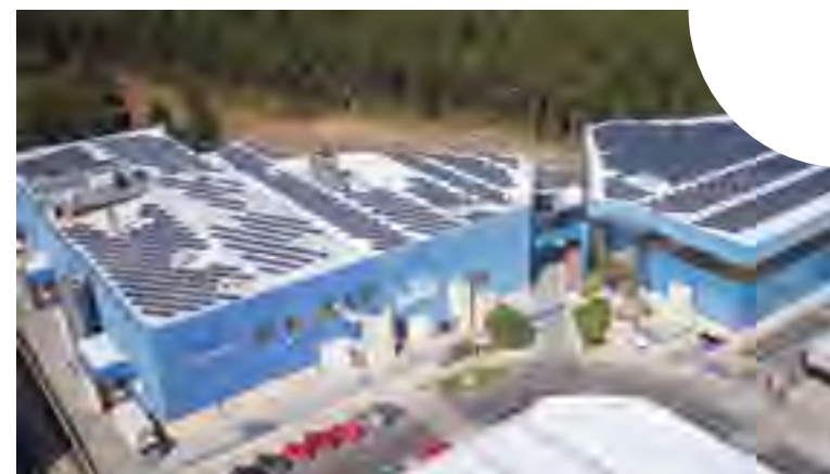
En ambas imágenes, instalación fotovoltaica en la cubierta de la fábrica de Congalsa.
