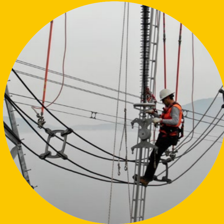
Instalación de sistema antitrepado por equipo de mantenimiento Maule.
