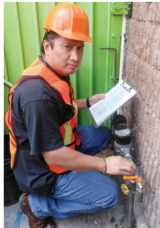
En 4press es indispensable el mantenimiento hidráulico.
