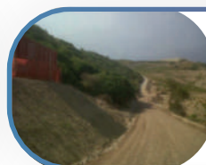
Viabilità interna e posa cavi
