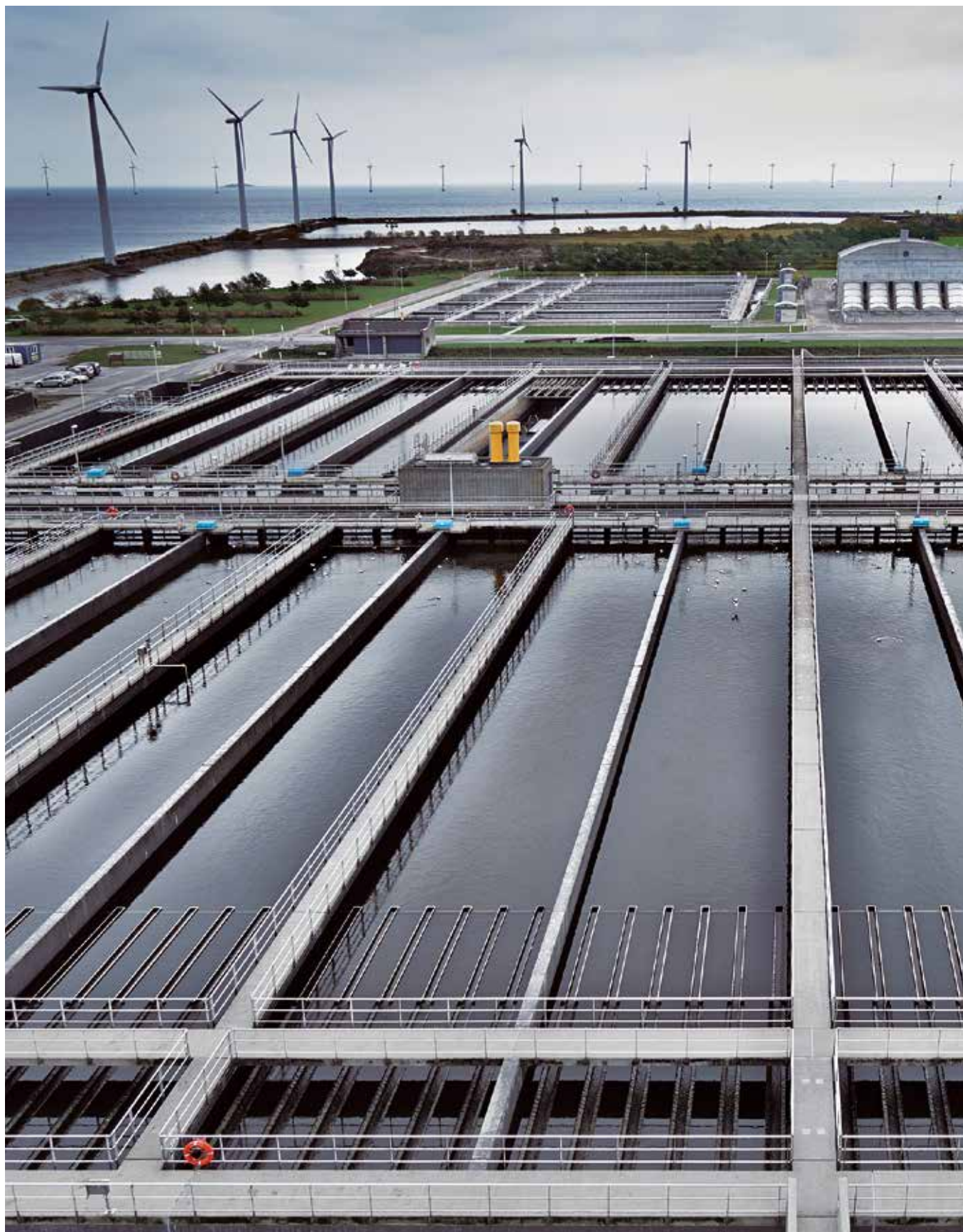
Rensbassiner ved Renseanlæg Lynetten.
