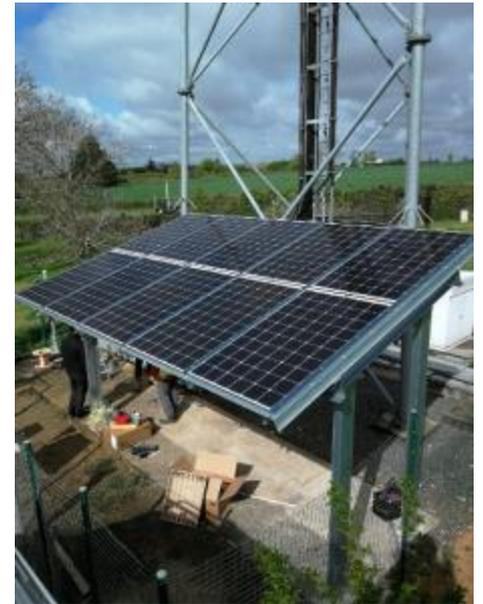
Les clients peuvent également installer leurs équipements sous l'ombrière. Ce positionnement à l'ombre permet ainsi d'optimiser le refroidissement des baies techniques.
