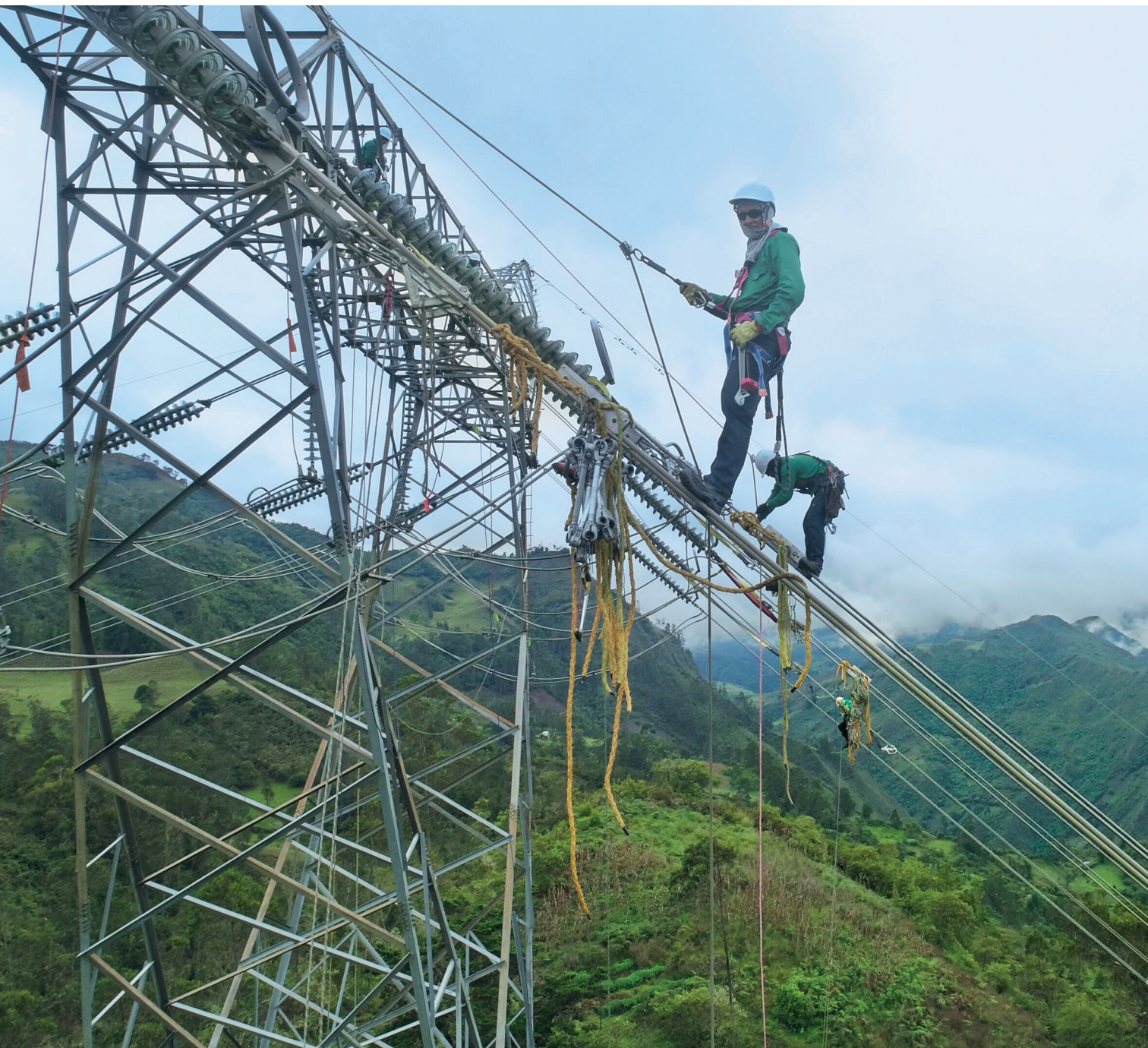
Mantenimiento de líneas de transmisión Circo-Guavio, torre 77
