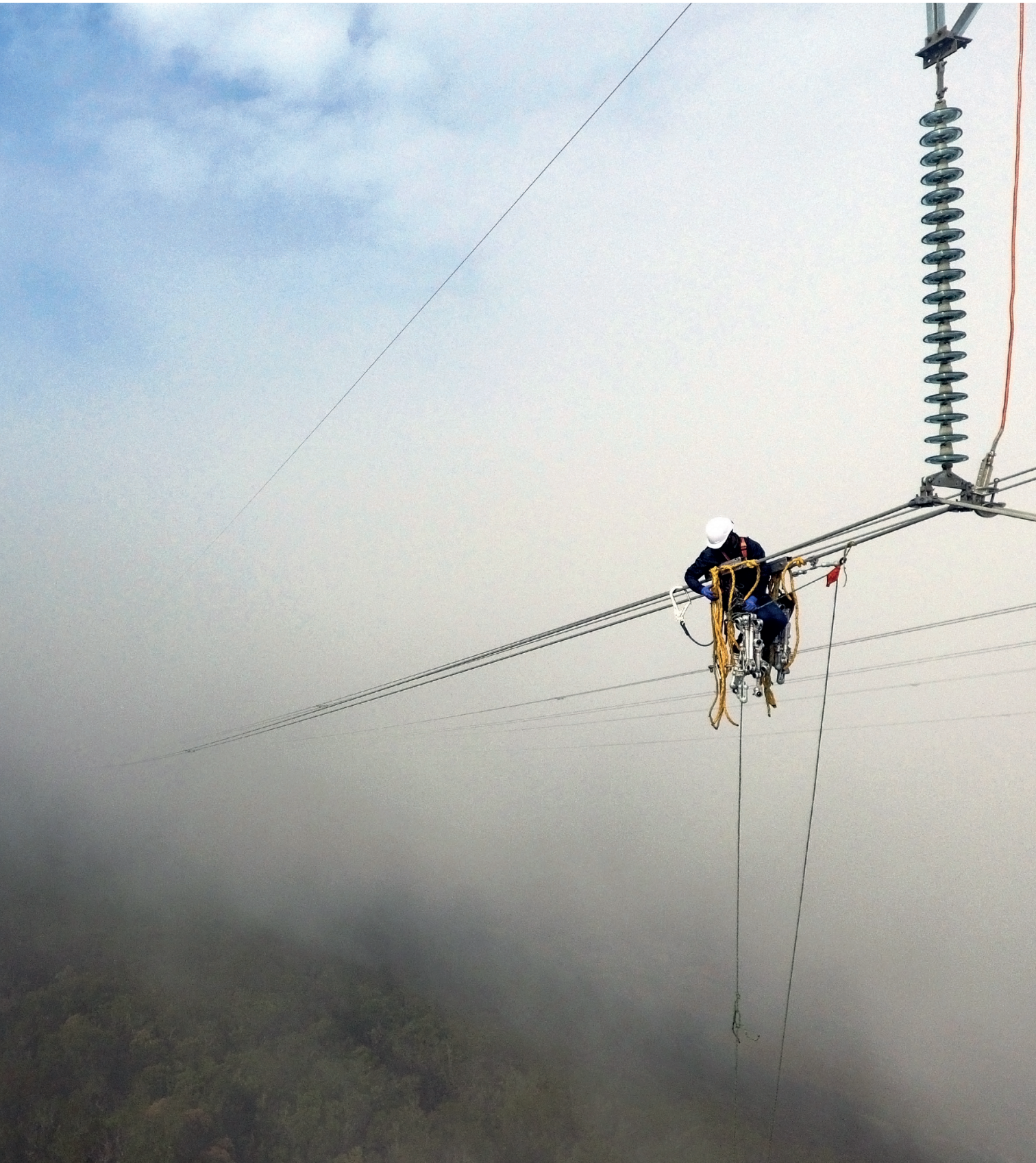
Mantenimiento línea de transmisión en Guasca, Cundinamarca
