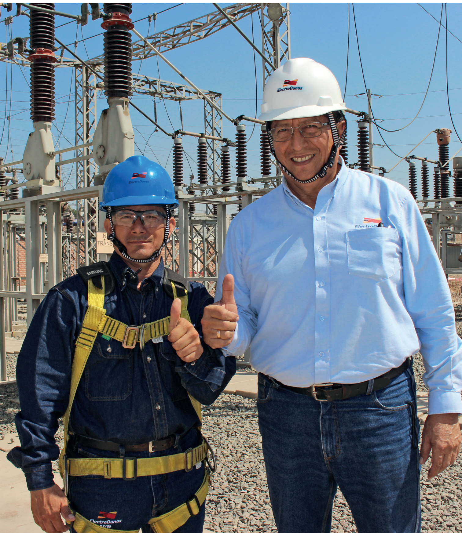
Colaboradores en instalación Ica, Perú
