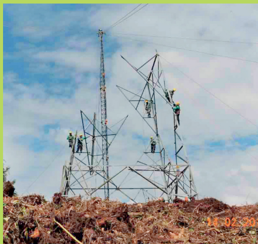
Jornada de construcción de la torre 309, segundo tramo proyecto Tesalia - Alférez en Pradera, Valle del Cauca
