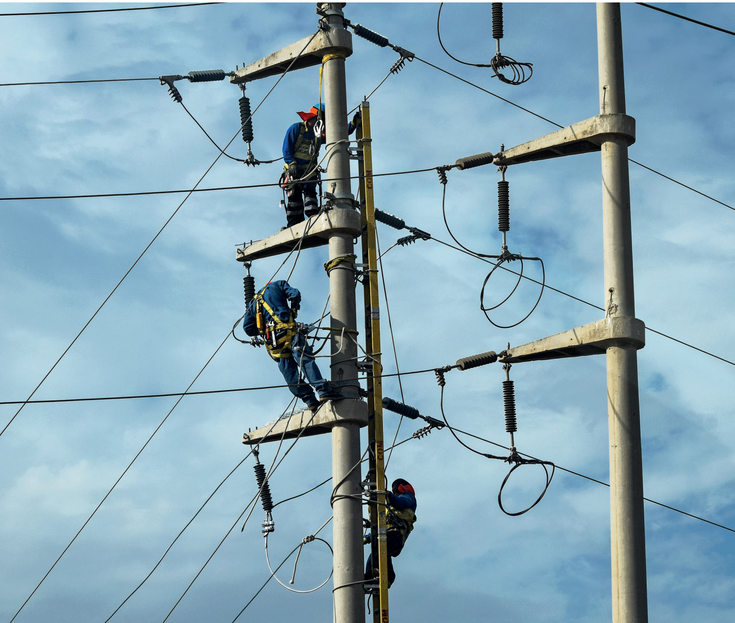
Colaboradores de Electro Dunas realizando mantenimiento en Perú
