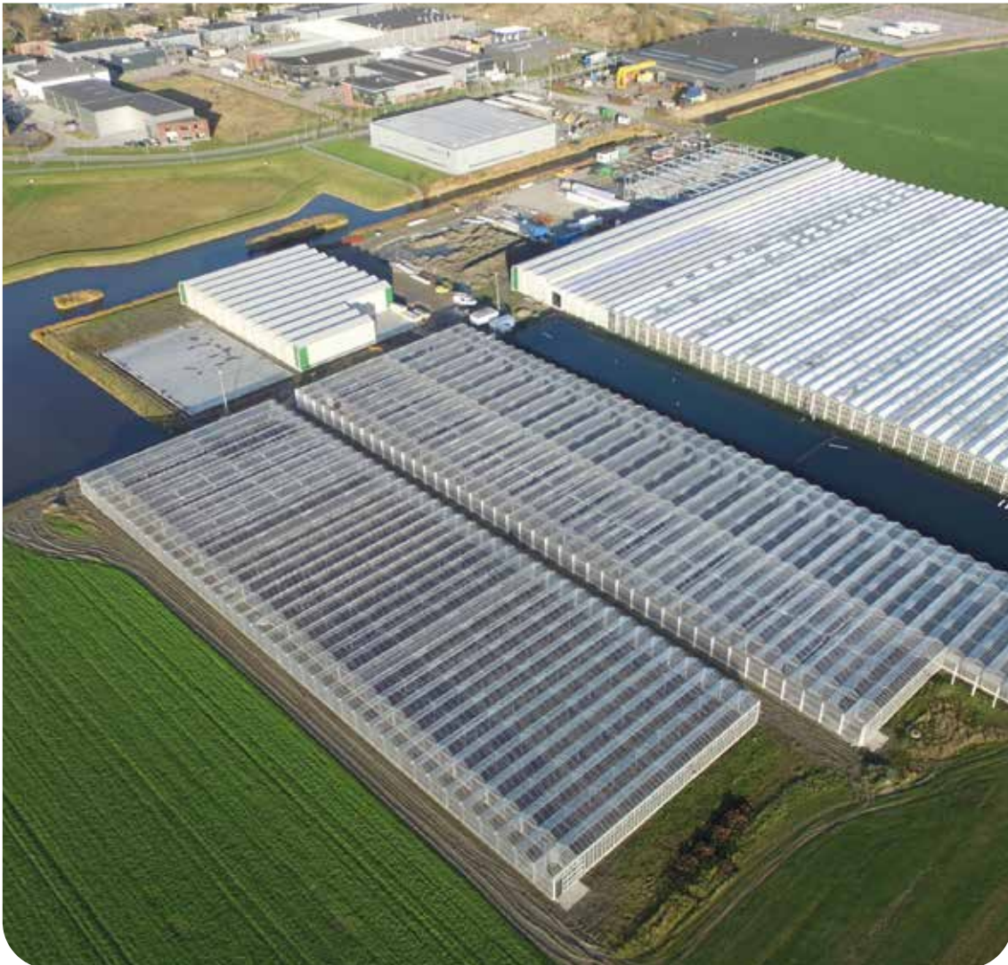
Hazera – instalaciones de Warmenhuizen (Países Bajos): la construcción de esta nueva estación de investigación permite mejorar el rendimiento en materia de agua y energía.
