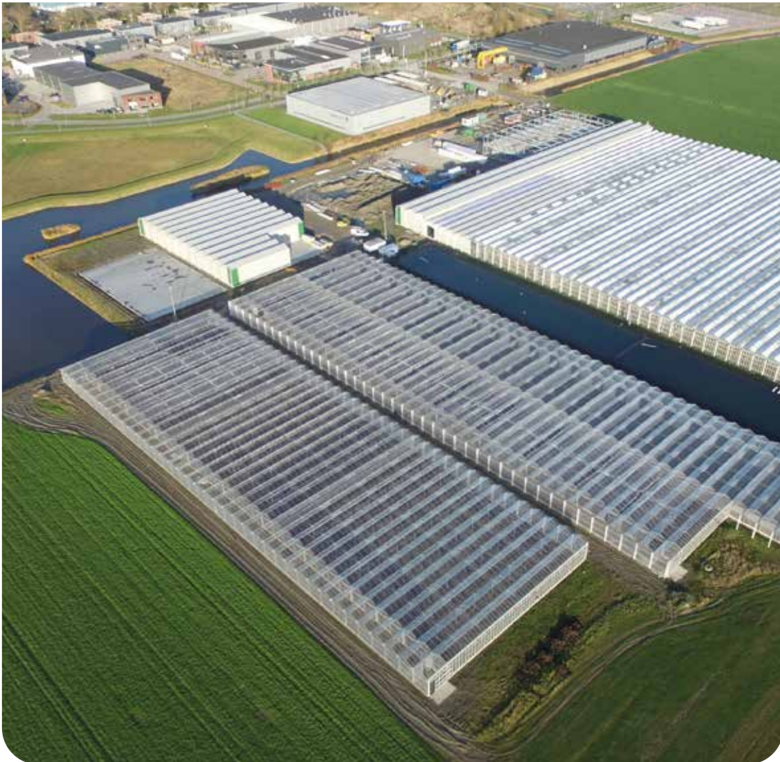
Hazera – site de Warmenhuizen (Pays-Bas) : la construction de cette nouvelle station de recherche permet l'amélioration des performances en matière d'eau et d'énergie.
