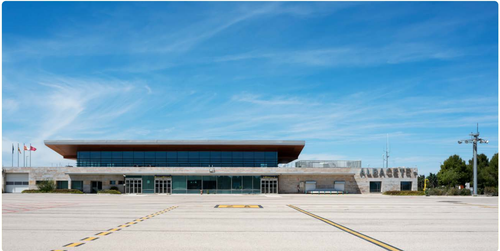
Terminal Aeropuerto de Albacete.
