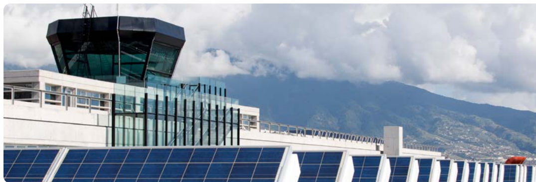
Placas solares instaladas en el Aeropuerto de La Palma.
