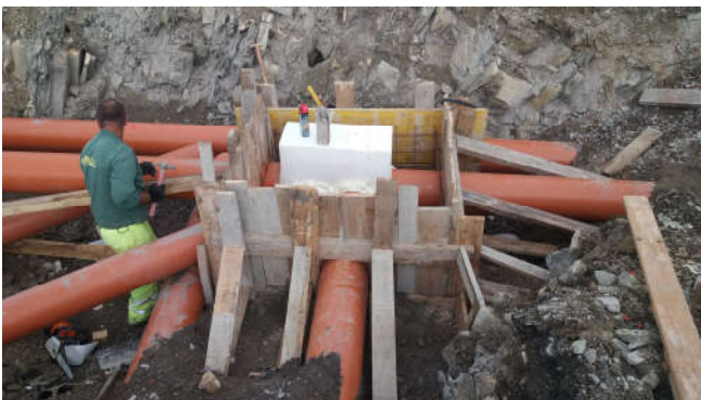
Encofrado de arqueta en las obras de urbanización del área 32 para el Ayuntamiento de Urduliz (Bizkaia).
