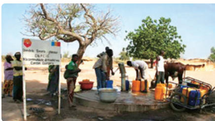
为古达瓦村打水井
