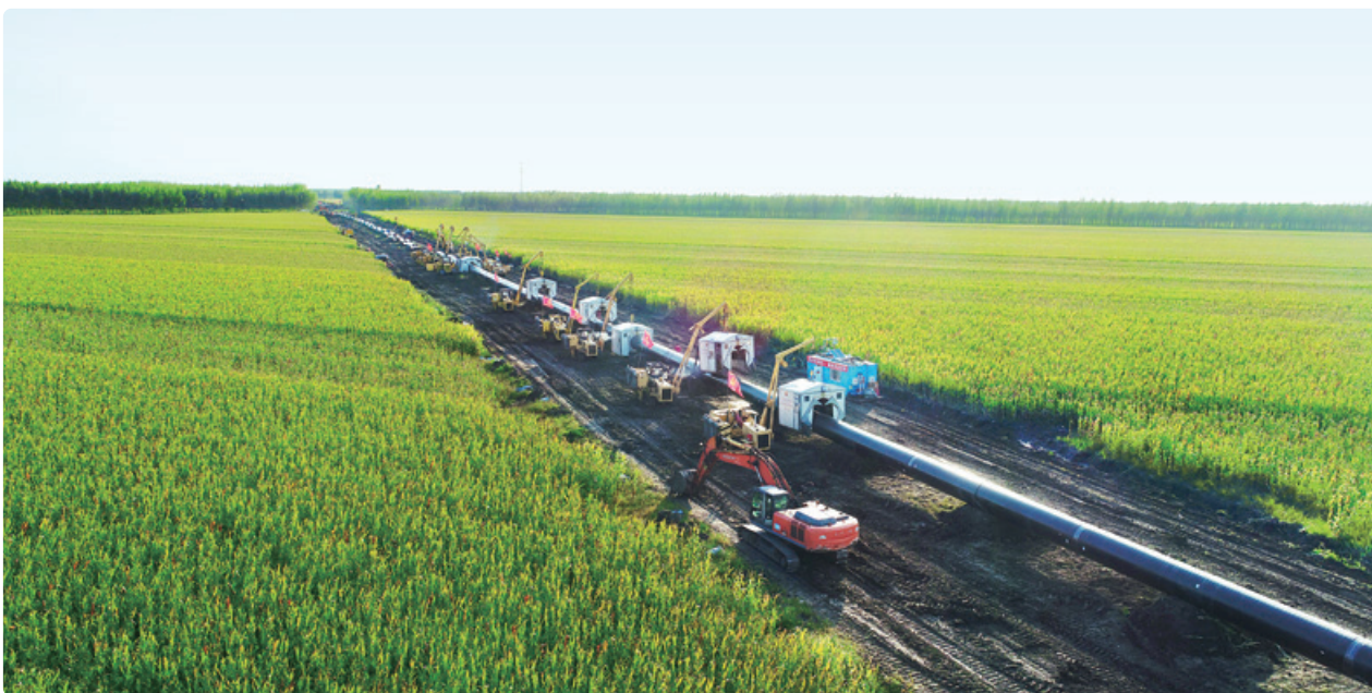
中俄东线天然气管道工程建设施工现场
