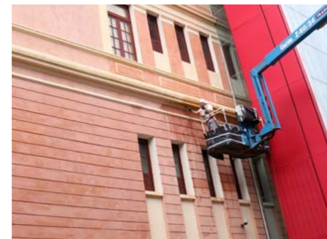
Obras de revitalização do Prédio Rosa, na fachada, em julho de 2018
