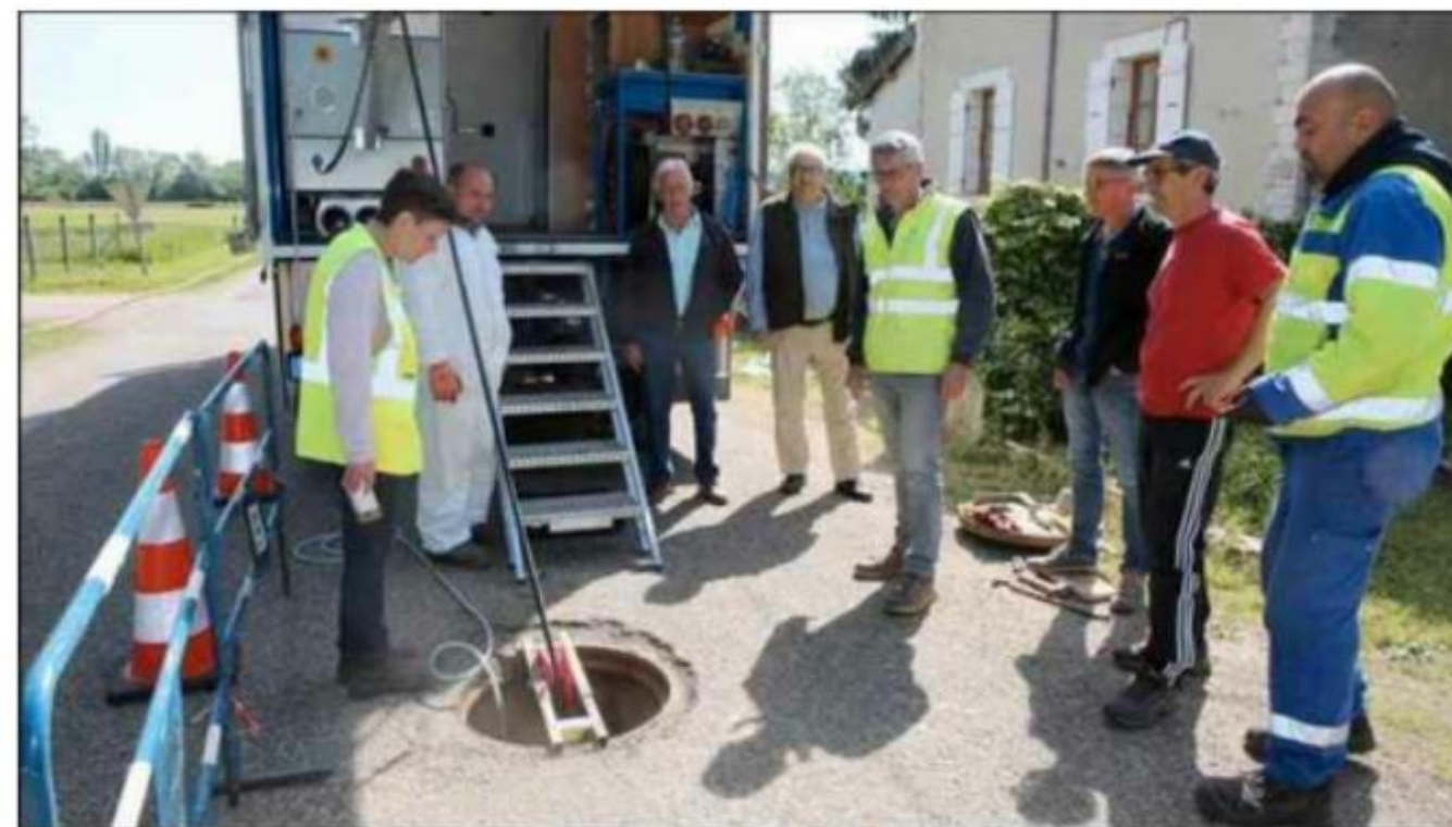
Réunion de chantier autour d'un regard. Photo Progrès/Bernard GIRARD
