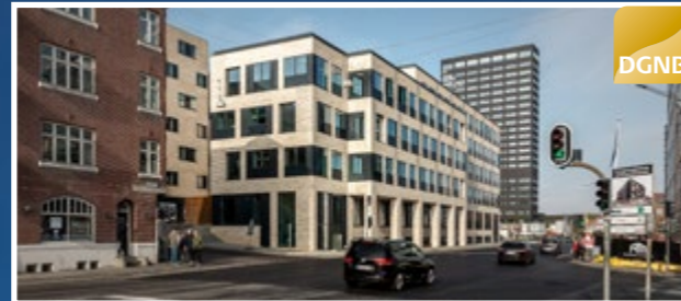
Frederiks Plads Company House, Aarhus C
