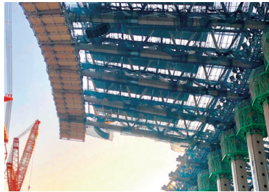
屋根 木材と鉄骨のハイブリッド工法
