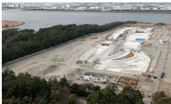
カヌー・スラロームセンター
