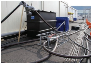
仮設給排水システムの事例
