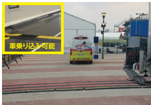
プラスチック板による防護事例
