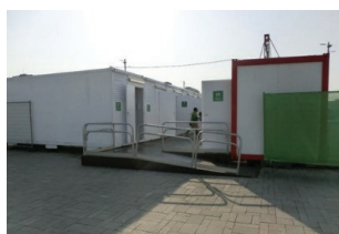
ユニットトイレの事例
