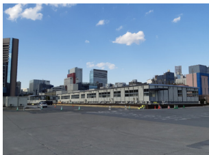
築地輸送デポの建設状況 (2020年2月)
