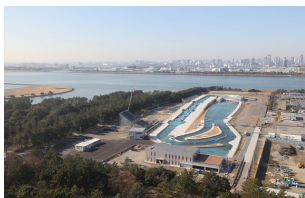
写真提供：東京都 カヌー・スラロームセンター
