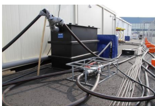
仮設給排水システムの事例
