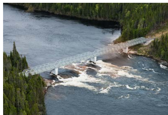
Passerelle de motoneige sur le site de la Romaine-1.
