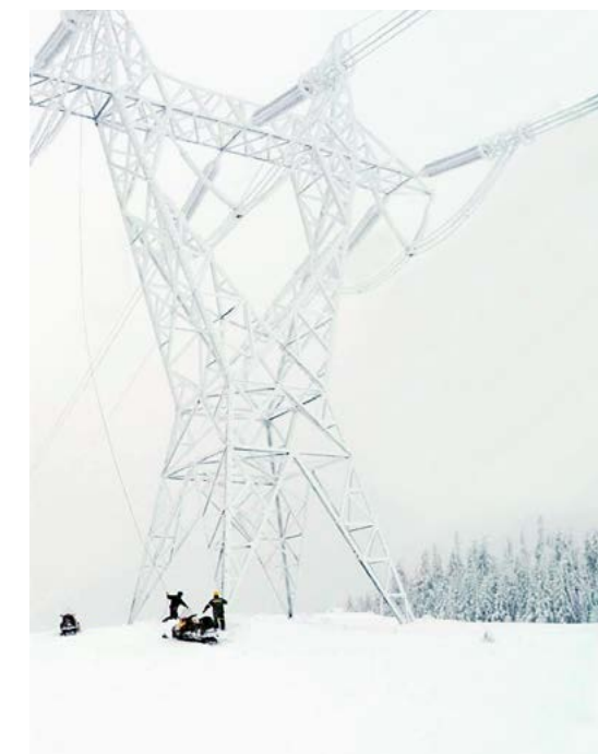
Réparation d'un câble de garde sur la ligne du Saguenay-Jacques-Cartier.
