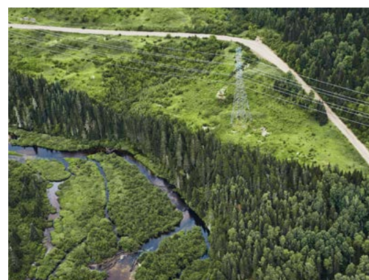
Tronçon de la ligne à 735 kV Micoua-Saguenay.
