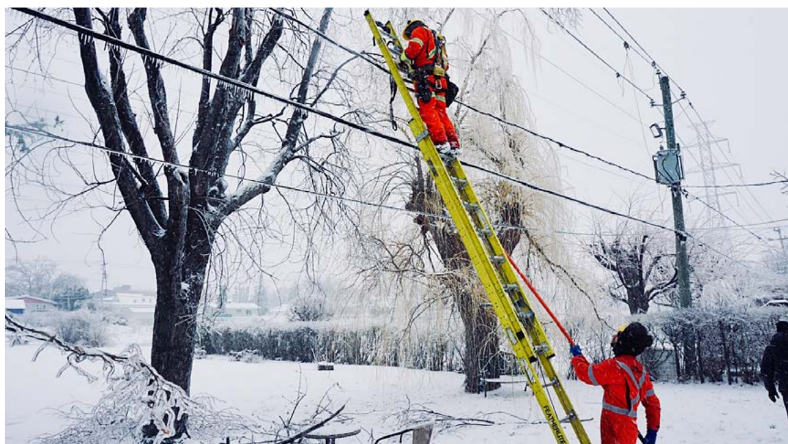
Une équipe de monteurs s'affaire à réparer les dégâts de la tempête de verglas d'avril 2019.
