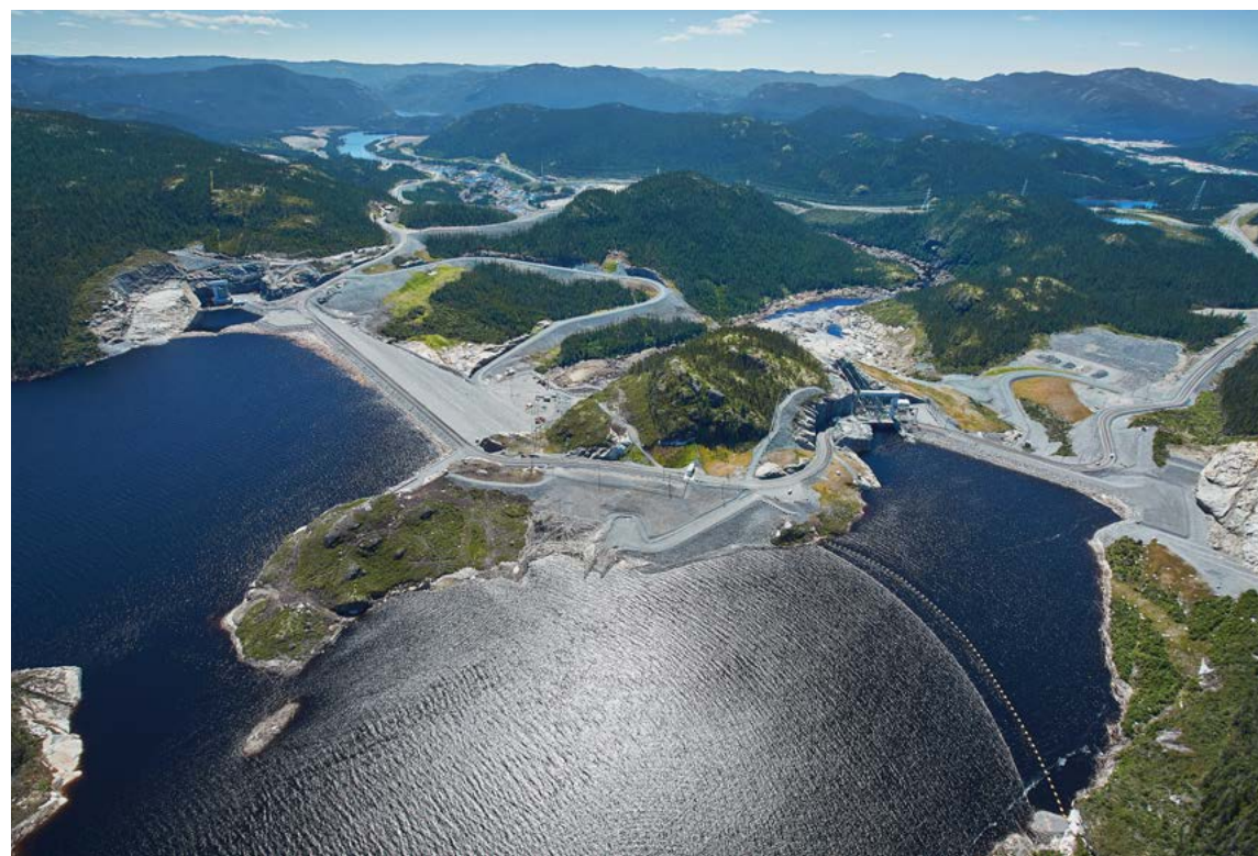
Centrale de la Romaine-3, mise en service en 2017.
