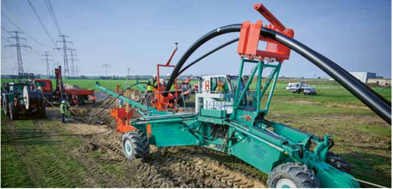
Als Test für die künftige Gleichstromverbindung SuedOstLink wird bei Wolmirstedt mit einem speziellen Pflug ein Erdkabel in den Boden gelegt.
