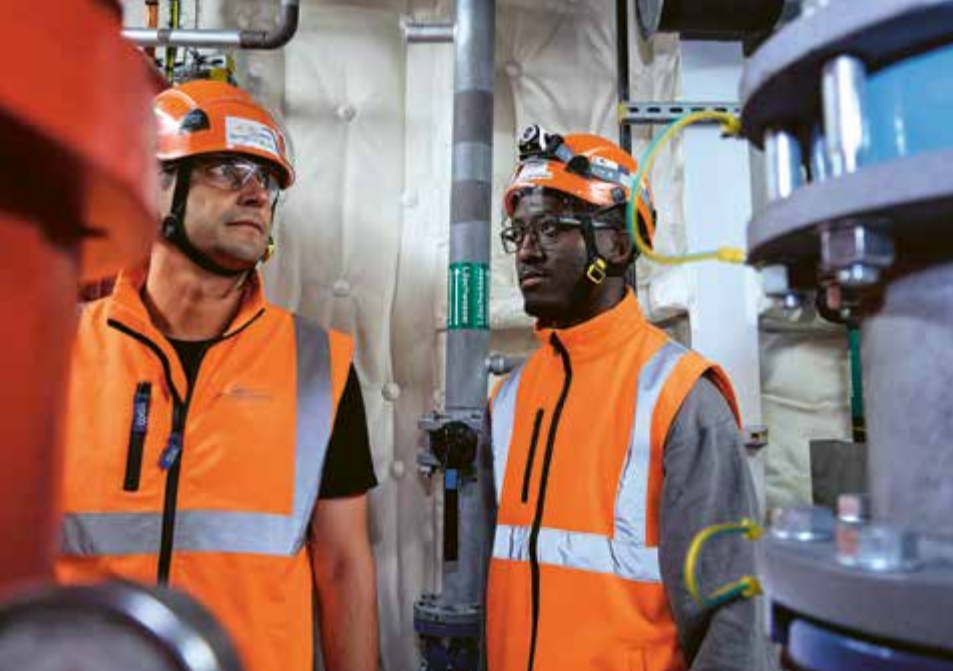
Kontrolle in der Schaltanlage auf der Offshore-Plattform Arkona.
