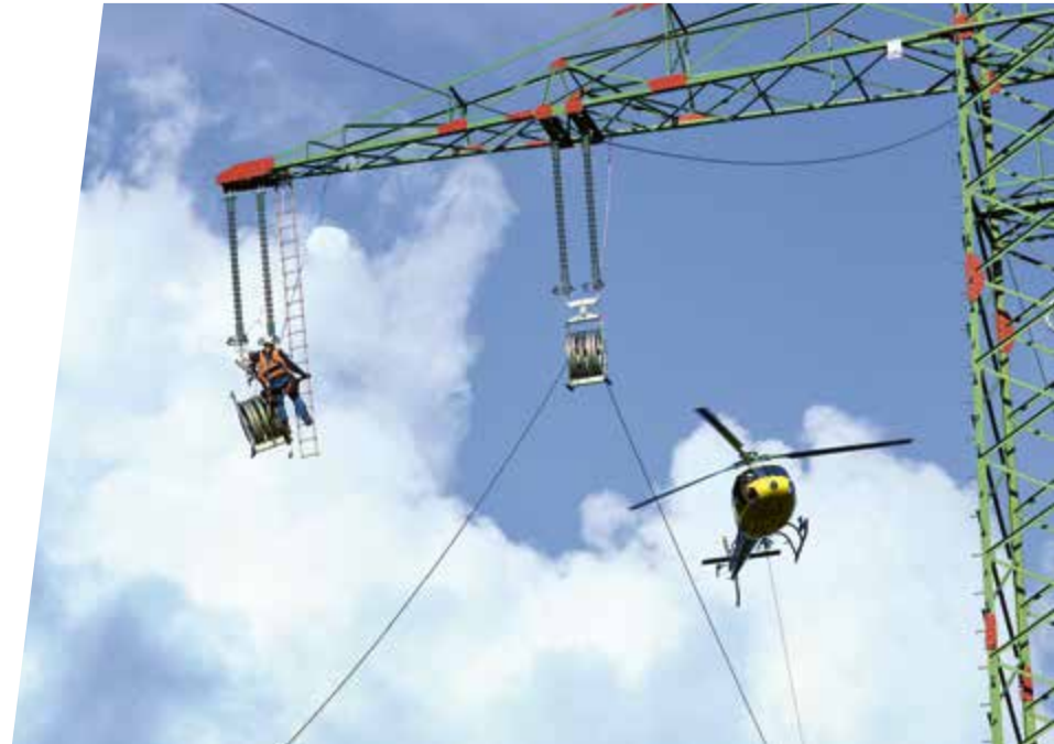
Bei Perleberg wird das Vorseil per Hubschrauber von Mast zu Mast gebracht.
