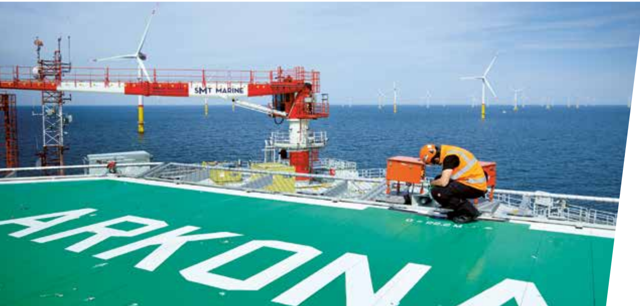
Kontrolle auf dem Hubschrauberlandeplatz.
