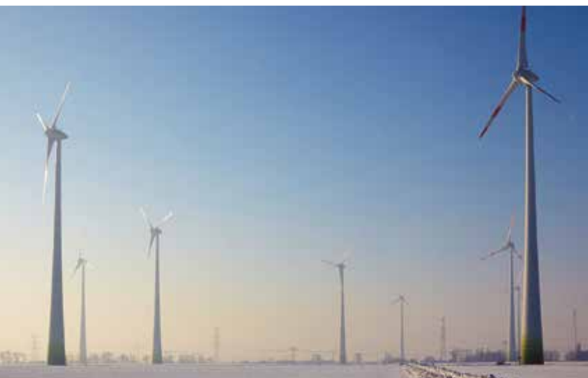
Windkraftanlagen in Brandenburg.
