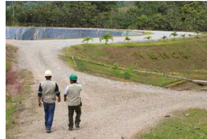
Complejo sanitario Wastuna. Nicaragua
