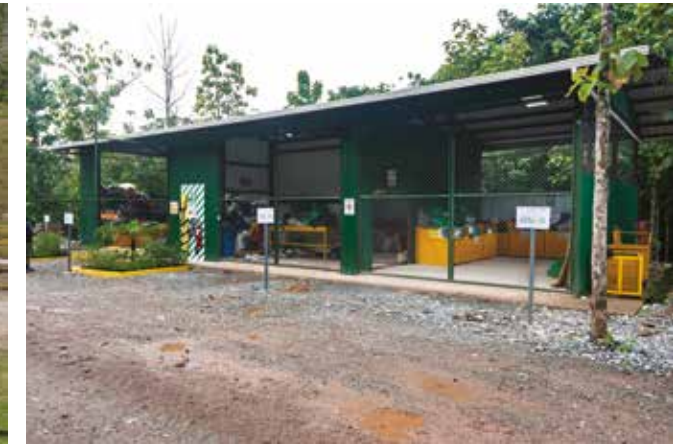
Complejo sanitario Wastuna. Nicaragua
