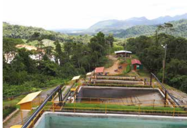
Sistema de tratamiento de aguas en exceso presa de colas San José. Nicaragua
