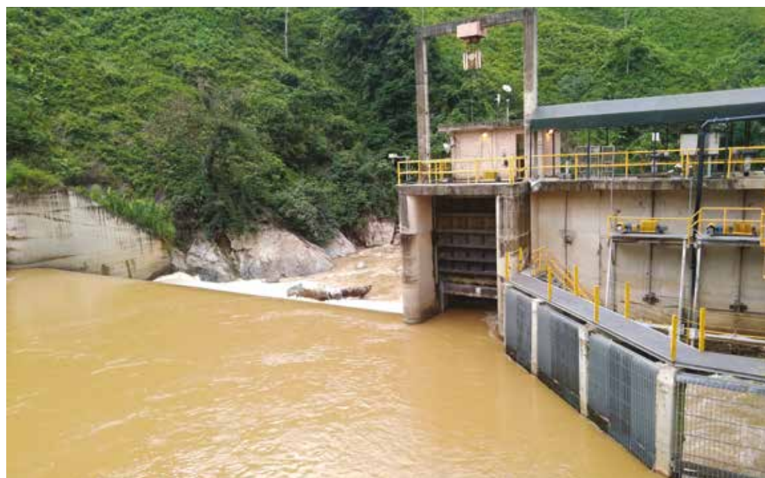
Central hidroeléctrica Providencia III. Colombia
