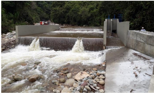
Acueducto (Bocatoma) - Socorro, Santander
