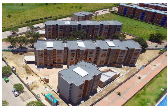
Ciudadela El Porvenir Manzanas 22AB Etapa VB viviendas Bogotá D.C. - 90 viviendas
