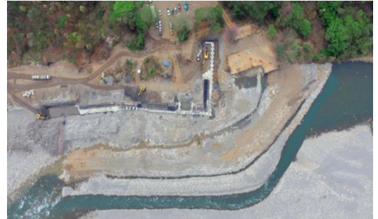
Protección ribereña Acueducto – Yopal, Casanare
