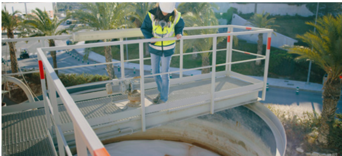
Planta de Tratamiento de Aguas en Parque Industrial de Cosentino en Cantoria (España)
