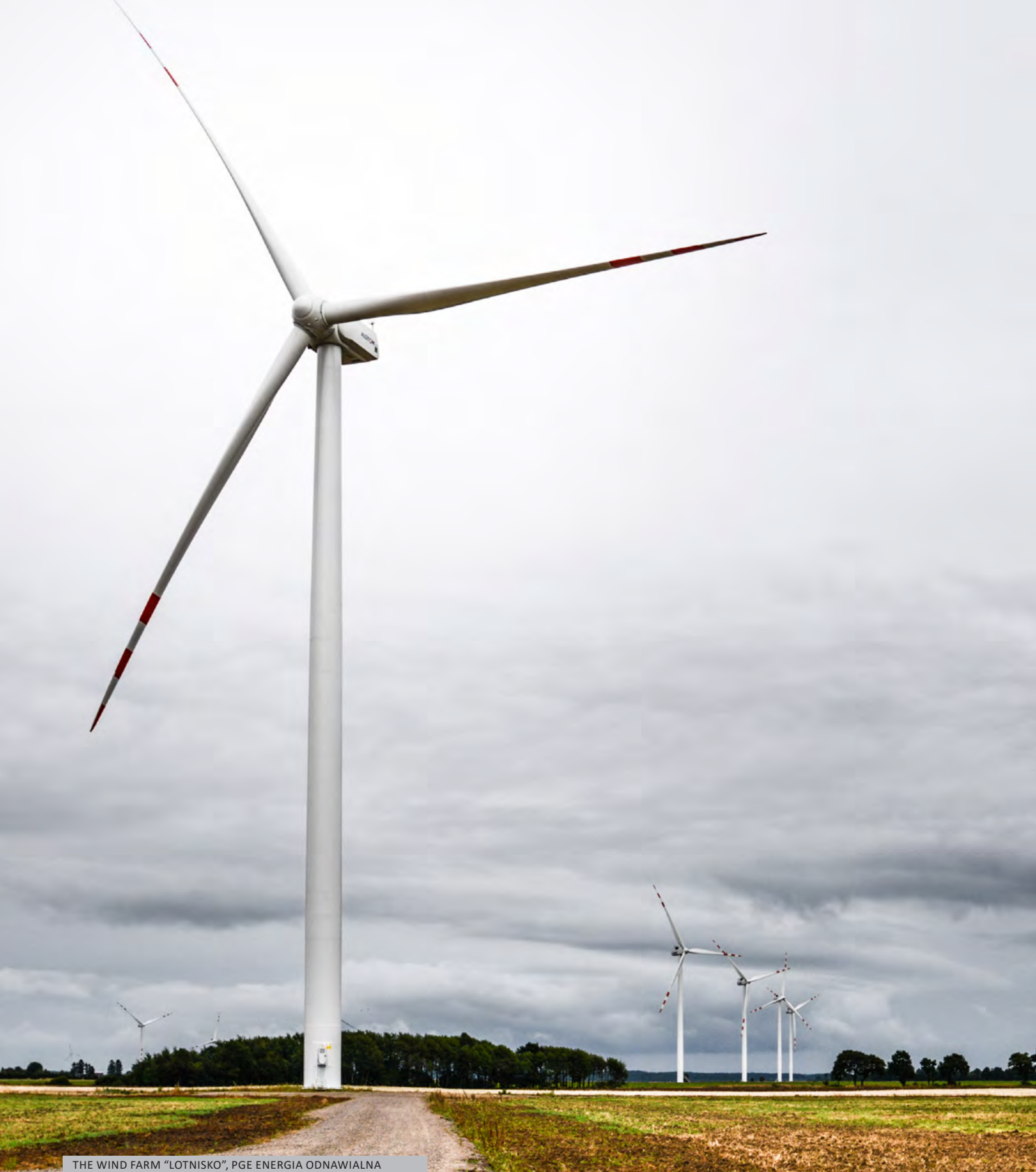
THE WIND FARM "LOTNISKO", PGE ENERGIA ODNAWIALNA
