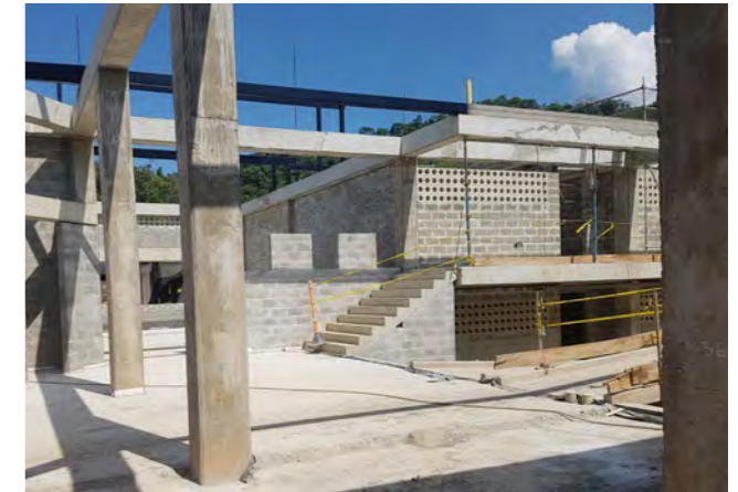
Construcción de la nueva sede de la Institución Educativa La Danta en el corregimiento de Jerusalén en Sonsón, Antioquia.
