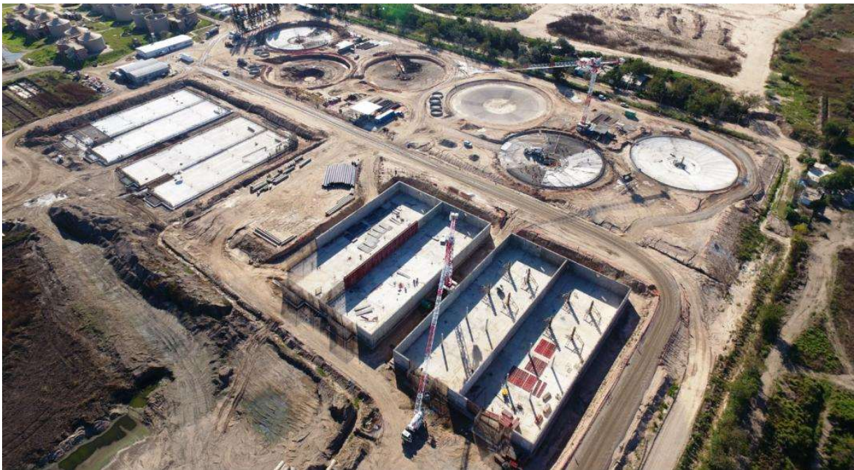
Colectores y Planta Depuradora de Líquidos Cloacales Córdoba.
