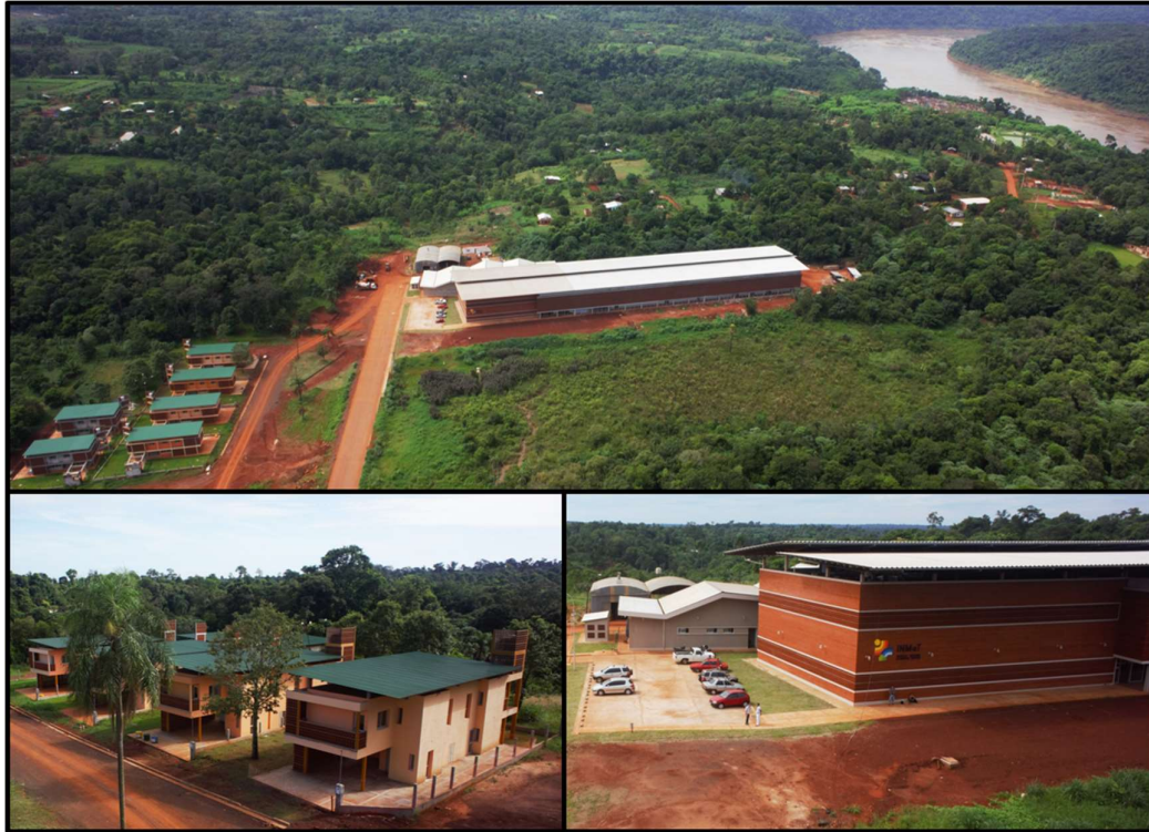
Construcción del Instituto Nacional de Medicina Tropical (I.N.M.E.T.) Puerto Iguazú
