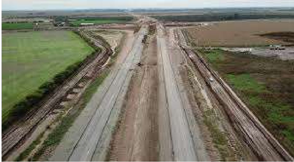
Construcción de Autopista en Ruta Nacional N° 8 Au Pilar - Pergamino Tramo II- Solís
