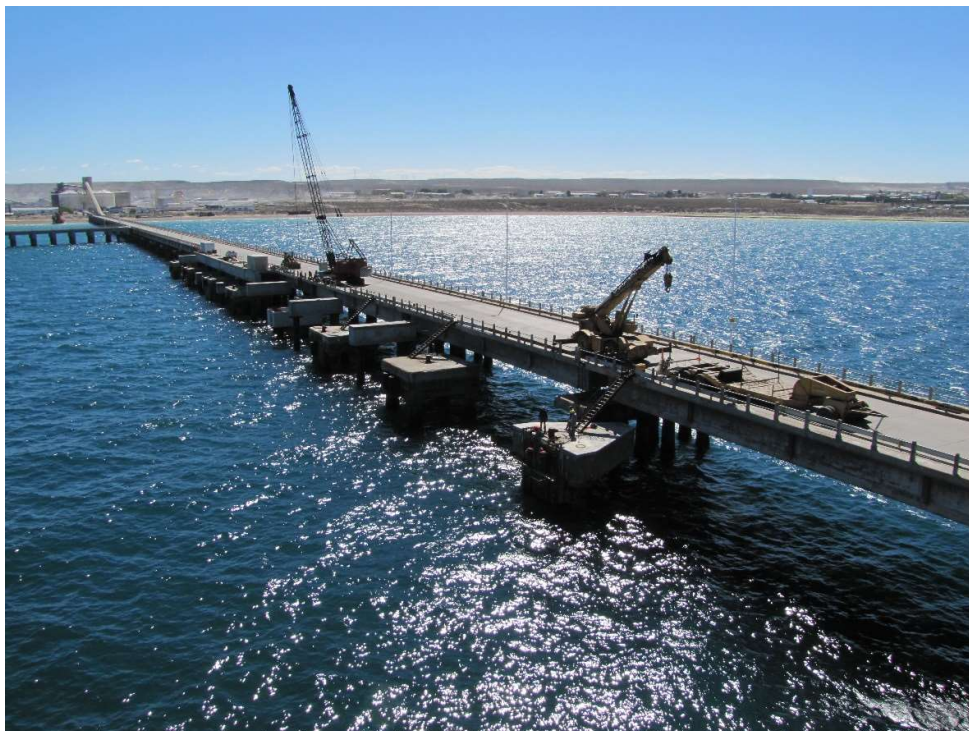
✓ Reparación de Pilotes Macizos Muelle Storni - Chubut
