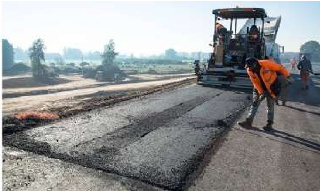
Obra OMSA en RN 8 - CV 8 - Corredor Central S.A.
