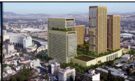
MIYANA - México, D.F. (2014-2018) *CCTV *Control de accesos *Detección de incendio *BMS *Voz y datos *TV USOS MÚLTIPLES
