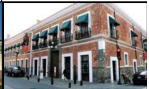
MUSEO AMPARO - Puebla, Puebla, (2010-2013) *Detección de incendio *Control de accesos *CCTV *Extinción Agente limpio NOVEC MUSEO
