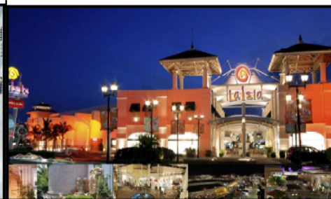
LA ISLA ACAPULCO - Guerrero, México. *CCTV *Detección de incendio *BMS *Sonido *TV *Voz y datos CENTRO COMERCIAL
