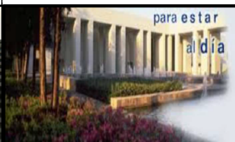
GRUPO NACIONAL PROVINCIAL - México, D.F. (1996-2013) *Detección de incendio *Control de accesos *CCTV CORPORATIVO
