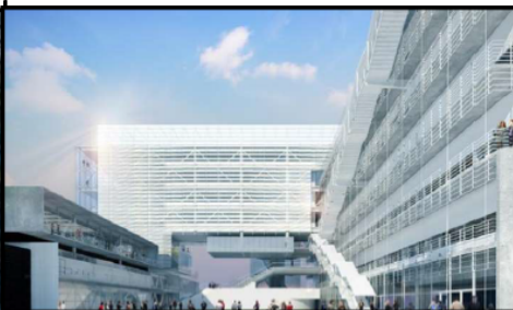
UNIVERSIDAD CENTRO - México, D.F. *Instalación del Sistema de Circuito Cerrado de Televisión *Control de accesos *Detección de incendio UNIVERSIDAD
