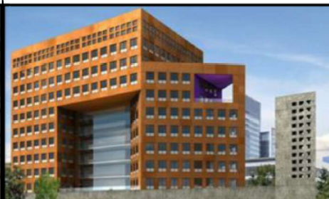
TERRACOTA 100 E INTERIORES DE COCA COLA FEMSA INVERTIERRA - México, D.F. (2010-2011) *Control de acceso *Detección de incendios *CCTV *Automatización *Red de voz y datos *Integración CORPORATIVO
