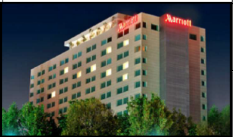
MARRIOTT REFORMA GRUPO DIESTRA - México, D.F. (2009) *Detección de incendios *CCTV *Automatización HOTEL
