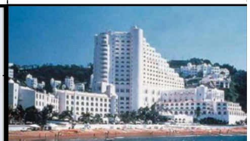
HOTEL SIERRA MANZANILLO - Manzanillo, Col. (1992) *Detección de incendio HOTEL
