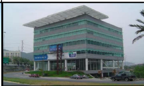
TAMAYO 100 - Monterrey, Nuevo León. *Detección de incendios *CCTV *Control de accesos *Automatización CORPORATIVO
