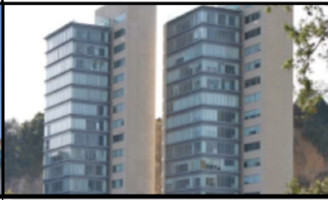
TORRE ALTA DINE - México, D.F. (2007-2008) *Control de acceso *Detección de incendios *CCTV *Automatización *Telefonía *Red de TV RESIDENCIAL
