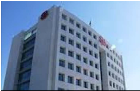
BANCO DEL BAJÍO - León, San Luis, Silao y D.F. (2008-2009) *Automatización *Control de acceso *Control de visitantes *Detección de incendio *CCTV *Sistema de Audio *Protección contra incendio CORPORATIVO
