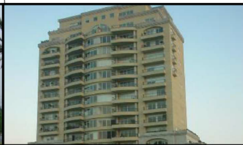
CLUB DE GOLF BOSQUES - México, D.F. *Voz y datos *Detección de incendios *CCTV *Control de accesos CORPORATIVO
