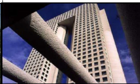
ARCOS BOSQUES - México, D.F. (1994-1995) *Sistema de cableado *Estructurado de voz y datos *CCTV *Control de accesos *Detección de incendio *Automatización CORPORATIVO
