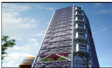
TORRE BANCOMER - México, D.F. (2015) *Control de acceso *CCTV *Detección de incendio *Sonido CORPORATIVO
