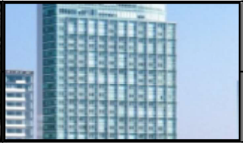
SANTA FE PADS ARQUITECTOMA - México, D.F. (2008-2009) *Control de acceso *Detección de incendio *CCTV *Telefonía RESIDENCIAL Y OFICINAS
