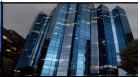
TORRE DIAMANTE - México, D.F. (2009-2013) *Detección de incendio *Control de accesos *CCTV *Automatización CORPORATIVO
