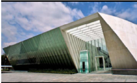
MUAC - México, D.F. (2008-2009) *Control de acceso *Detección de incendio *CCTV *Automatización *Red de Voz y Datos *Extinción de incendio Agente limpio FM200 MUSEO
