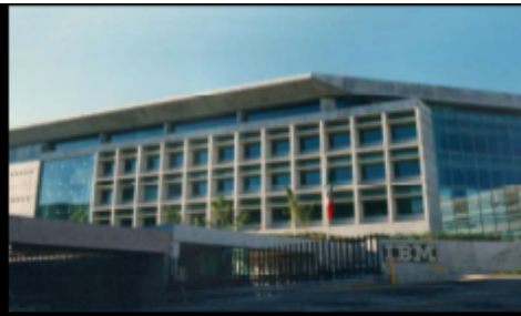
IBM DE MEXICO - México, D.F. (1992-2013) *Detección de incendio *Control de accesos *CCTV *Extinción *Automatización CORPORATIVO
