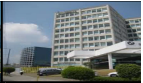
BANOBRAS - México, D.F. *Detección de incendio *Control de accesos *CCTV CORPORATIVO
