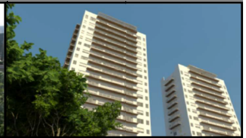
HIGH TOWERS SONATA ARQUITECTOMA - Puebla (2013) *Control de accesos *Detección de incendios *CCTV *Telefonía *Red de TV RESIDENCIAL
