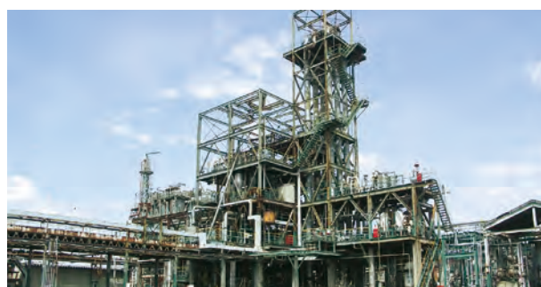
ポリエチレンプラント
