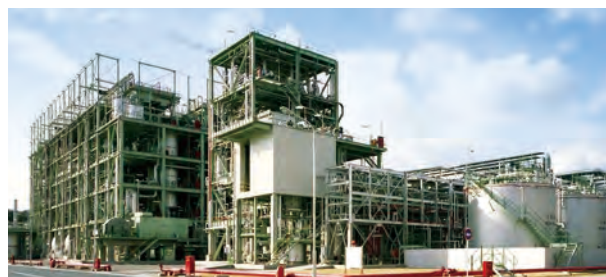
MDI製造設備
