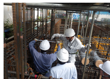
建設現場における品質管理検査
