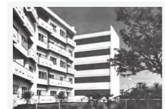
1963年 「コープ竹の丸」の建設で、マンション分野に進出
