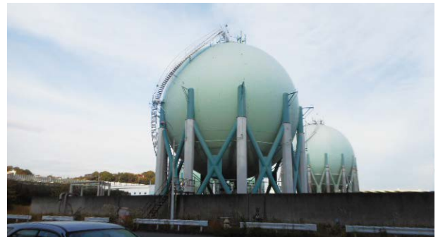
球形タンクのブレース(筋交い)補強
