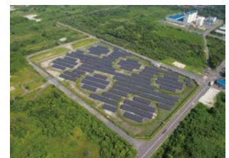
下松メガソーラー発電所
