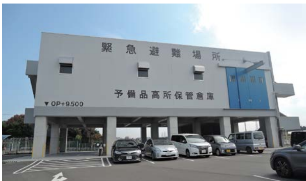
高所保管倉庫(堺製油所)
