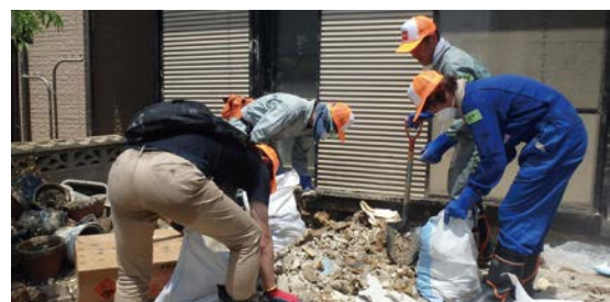
瓦礫撤去作業の様子
