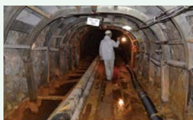
花輪鉱山 坑道点検の様子
