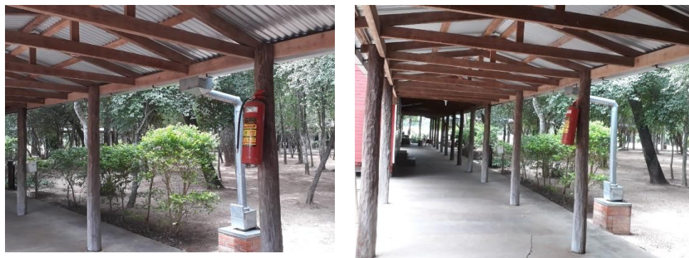
Sistema de captación de agua de lluvia
