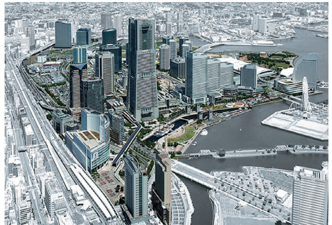
みなとみらい21中央地区 (神奈川県横浜市)
