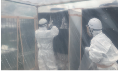
RCF含有製品の撤去作業
