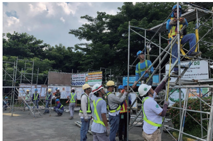
建設用足場の組立訓練
