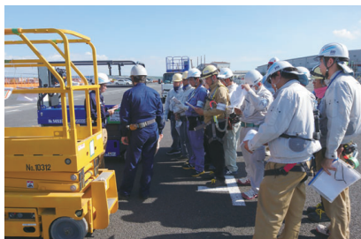
高所作業車運転教育
