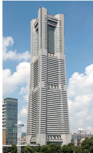
横浜ランドマークタワー 空調設備
