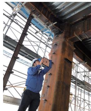
現場作業風景
