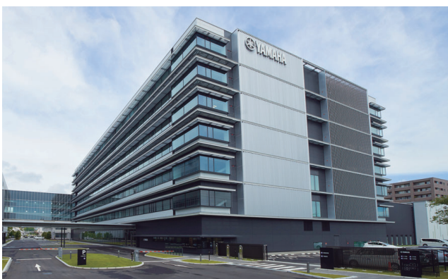
ヤマハ株式会社本社21号館 (静岡県浜松市)
