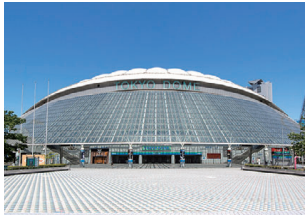
東京ドーム 空調設備
