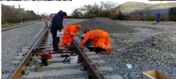
Figura 4-1 Lavori della Ferone Pietro & C SRL
