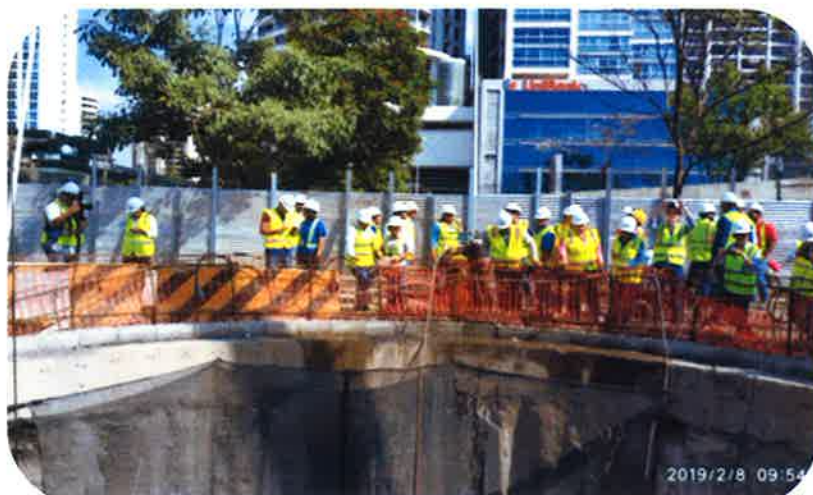
Construcción de las Obras de mejora al sistema de alcantarillado Sanitario de Punta Paitilla y Punta Pacífica.
