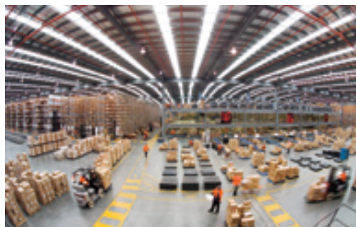
トール社のロジスティクス施設
