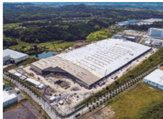
建設中の和歌山製作所 (2019年7月末撮影)
