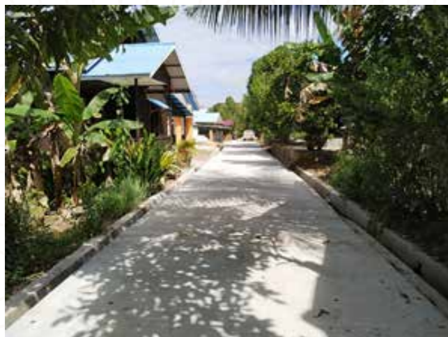
Betonisasi gang Pelangi, RT.39, Bukit Pelangi, Desa Teluk Lingga, Sangatta Utara
