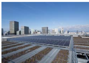
日本生命本店(東館) 屋上
