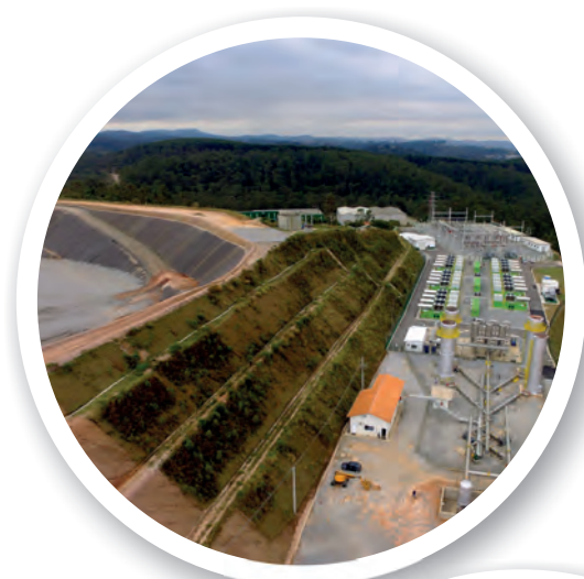
UVS Essencis Aterro e geração de energia Caieiras - SP
