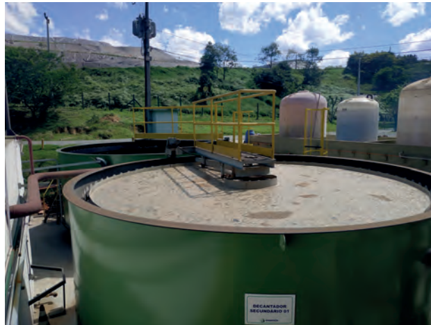
Processo de Tratamento de Efluentes - decantadores e efluente tratado após a nanofiltração UVS Essencis Joinville - SC
