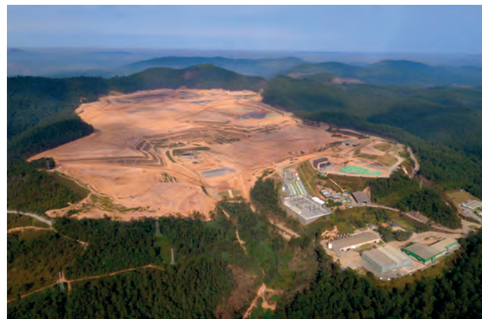
UVS Essencis - Vista aérea do aterro sanitário - Caieiras - SP
