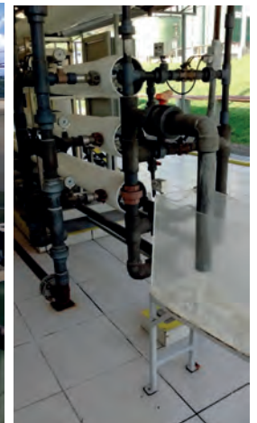
Processo de Tratamento de Efluentes - decantadores e efluente tratado após a nanofiltração UVS Essencis Joinville - SC
