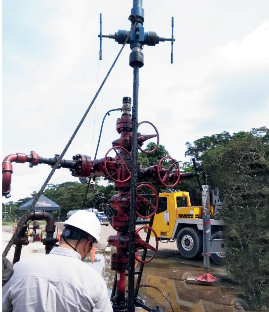
Equipo de fondo con presencia de arena, mantenimiento de la bomba jet
