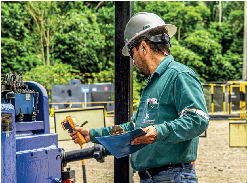
Monitoreo de parámetros en la operación con bombeo hidráulico
