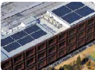
Meiji Co., Ltd. Osaka Plant
