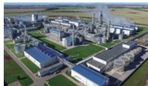
アンモニアプラント
