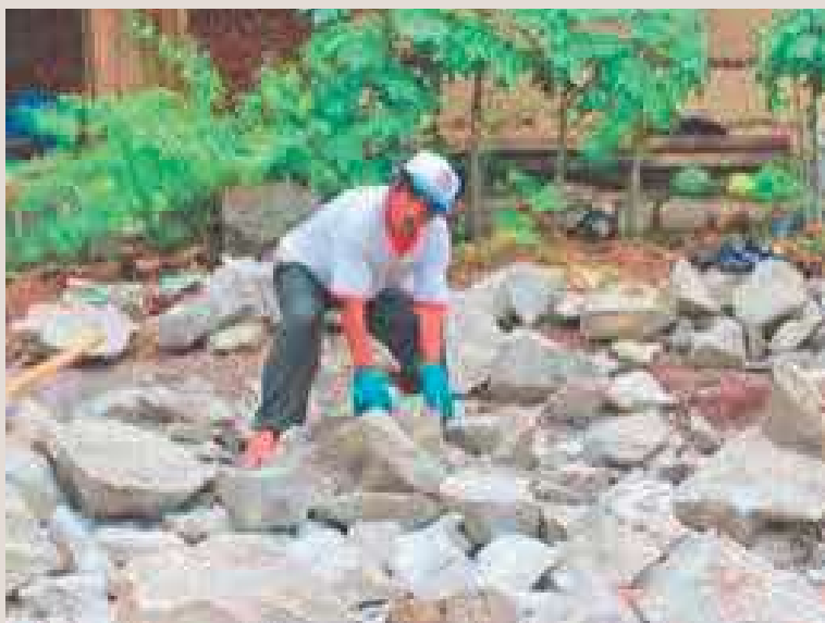
Natividad Acuña Mejía, Movilizando piedra para Construir las Terrazas y los Cercos, en el Caserío Muya.
