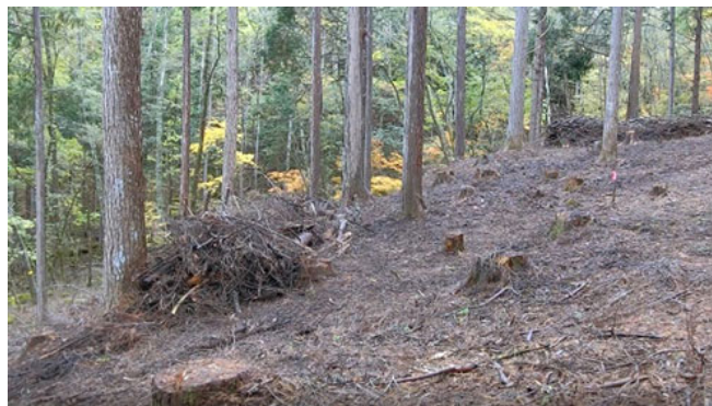
地拵え作業後：地面が露出し植栽が可能な状態となる
