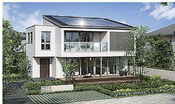
スマートハウス外観
