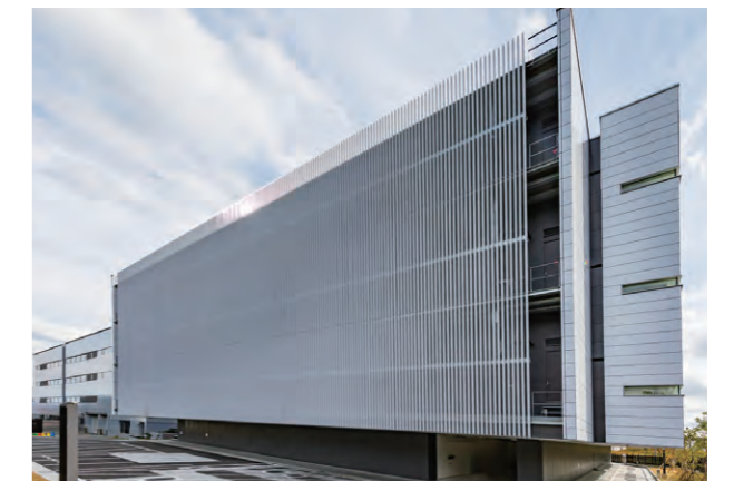
netXDC三田第2センター
